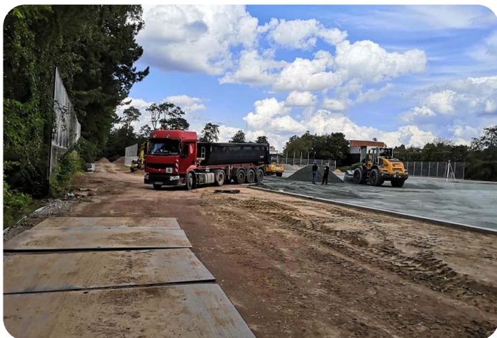
BAUARBEITEN AM KUNSTRASENPLATZ
